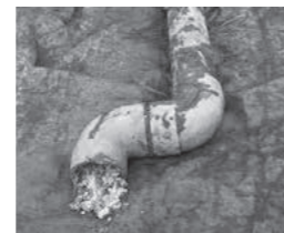
↑切断した排水管
