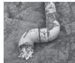
↑ 切断した排水管
